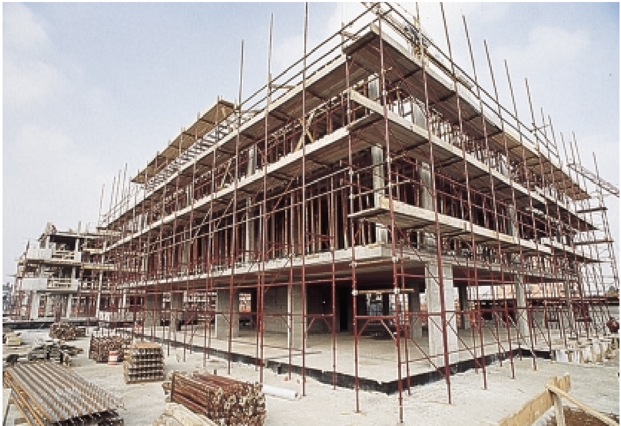
Un cantiere di costruzione e demolizione
